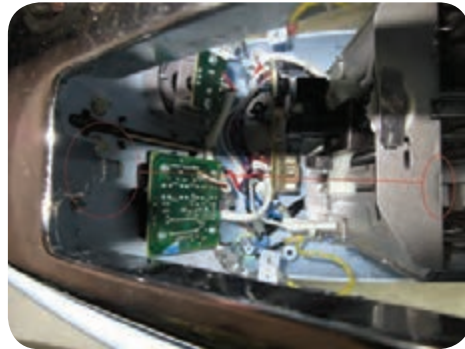
شکل ۵۷-۶ محل اتصال قسمت‌های فلزی
